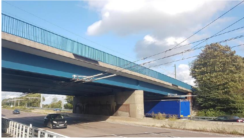
Afbeelding 4.4 Bovenleiding onder laag viaduct [e-highway Siemens]
